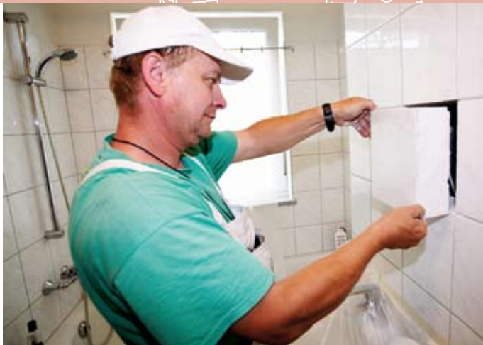
■ In raumhoch verfliesen Bädern entfernt der ausführende Fachbetrieb eine Fliese, öffnet die Wand des Installationsschachtes...
