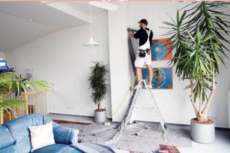
■ Das Rockwool Einblasdämmsystem lässt sich nachträglich ohne gravierende Eingriffe in die Bausubstanz in bestehende Installationsschächte einbringen.
